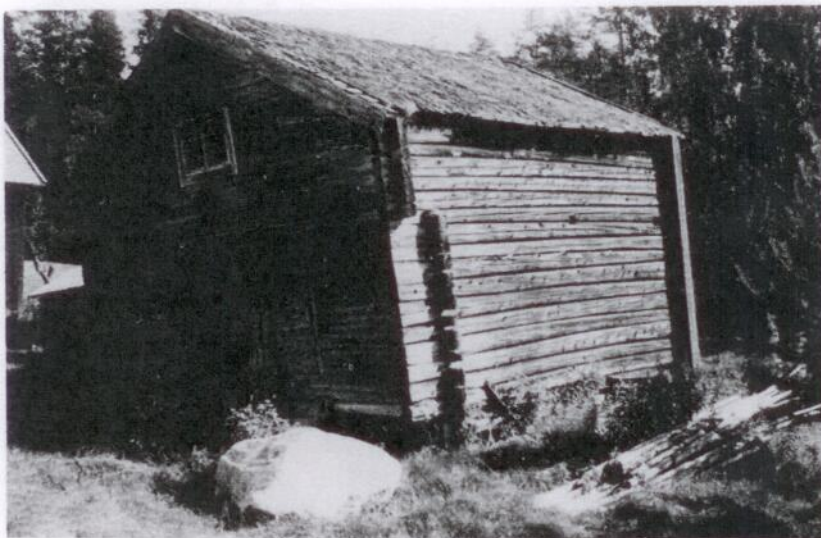
Flottningsinspektör Erik Johanssons gamla häbrä. Det är från Johan Petter Nilssons tid och har bl. a. under generationer innehållit stora mängder älgkött, som johanssönerna fört hem till gården.
