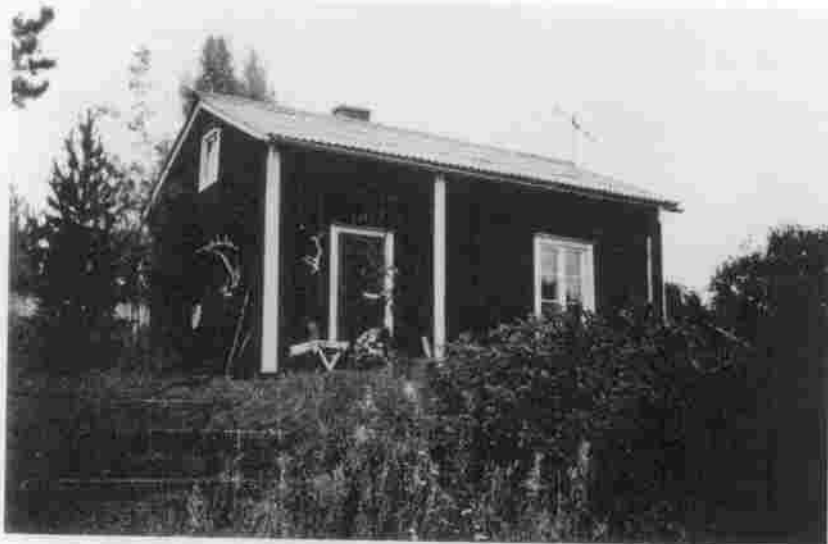
Det Hallmanska båtsmanstörpet i Movattnet, socknens enda kvarvarande. Denna enkelstuga uppfördes före 1850. Den användes nu till sommarstuga.
